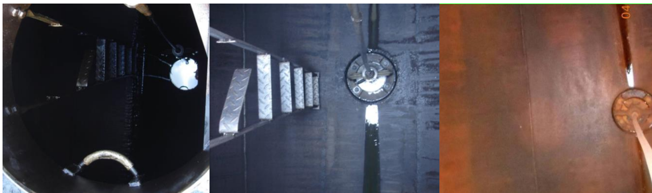
а) Цистерна до очистки б) Цистерна после ХМТ в) Цистерна после пропарки Рисунок 3 – Внутреннее состояние котла цистерны
